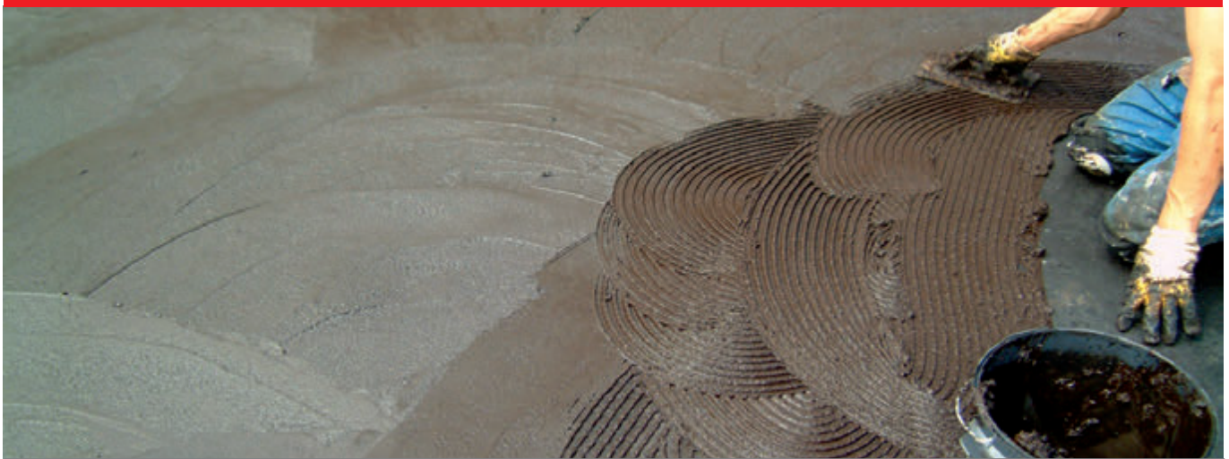
Ząbkowana paca ułatwia uzyskanie właściwej grubości warstwy.
