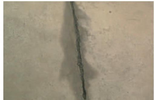
Bez odpowiedniego uszczelnienia, szczeliny dylatacyjne staną się miejscem przecieków.
