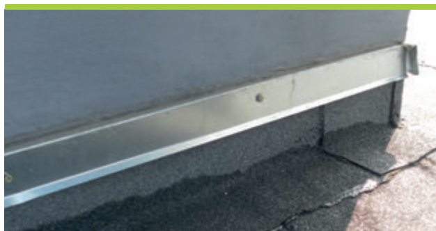
W pokryciach papowych szwy przy obróbkach i załamaniach, są szczególnie narażone na przecieki i wymagają dużej staranności.
