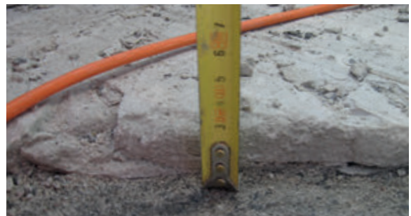
Częstym błędem jest wykonanie zbyt cienkiej warstwy spadkowej.
