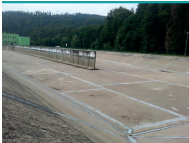
Dylatacje w dnie zbiornika betonowego z wykorzystaniem IZOHAN taśmy uszczelniającej .
