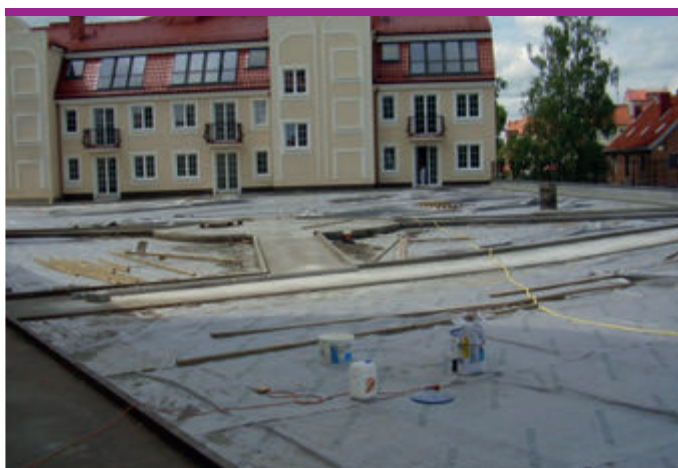
Wykonywanie warstwy filtracyjnej.
