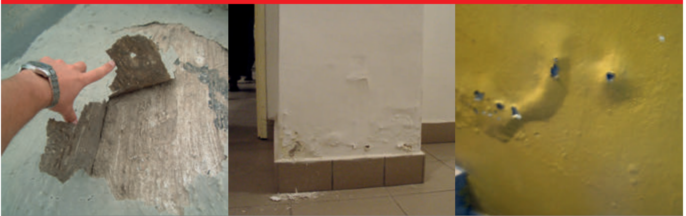
Odszpajanie powłok malarskich, wykwity na ścianach, purchle, to typowe symptomy zawilgocenia ścian.
