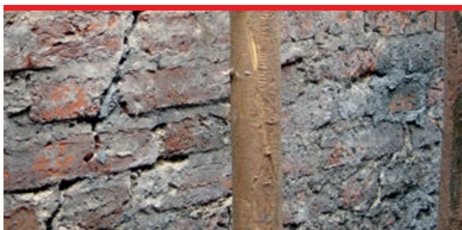
Przed nałożeniem izolacji rysy należy rozkuć na 20 mm a powstałą bruzdę wypełnić.
