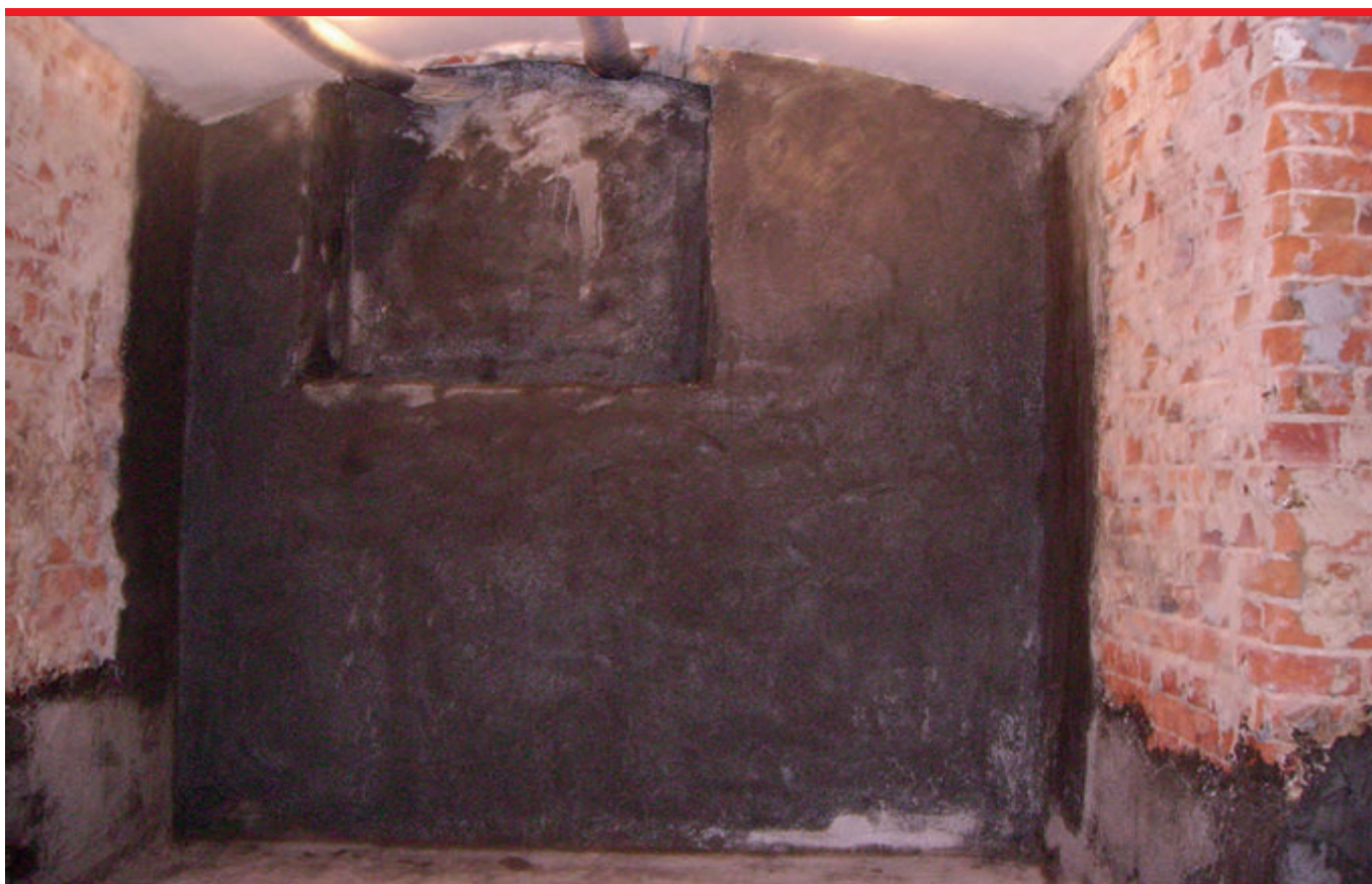
Na ściany наносimy mikrozaprawę uszczelniającą.
