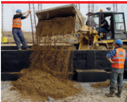
Przy zasypywaniu należy upewnić się, że izolacja nie zostanie uszkodzona.
