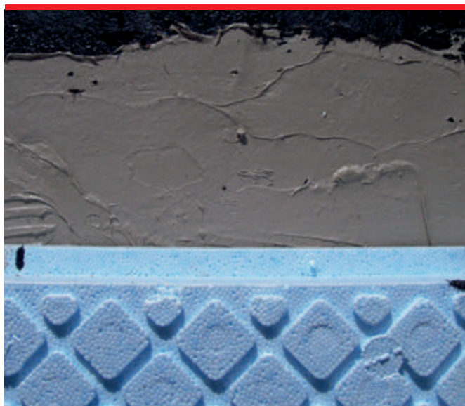
Technika nakładania zapewnia utworzenie szczelnej warstwy ochronnej.
