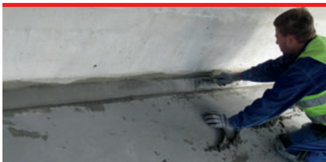
Fasety z zapraw PCC aplikujemy na izolację z EKO 1K (ekofolii wysokociśnieniowej 1-skl.) lub bezpośrednio na podłoża mineralne.
