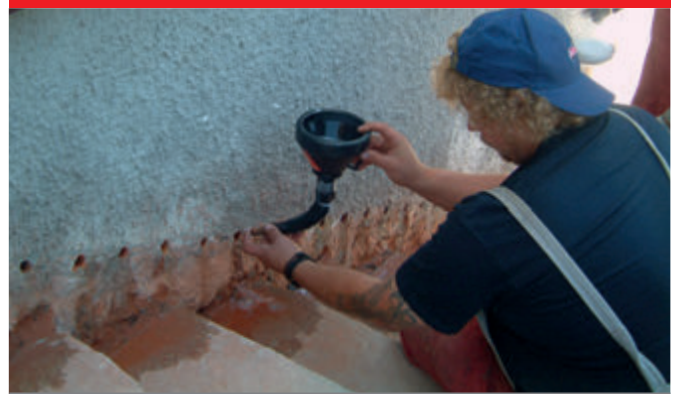
W przypadku iniekcji grawitacyjnej preparat wlewamy otworów aż do pełnego nasycenia muru.
