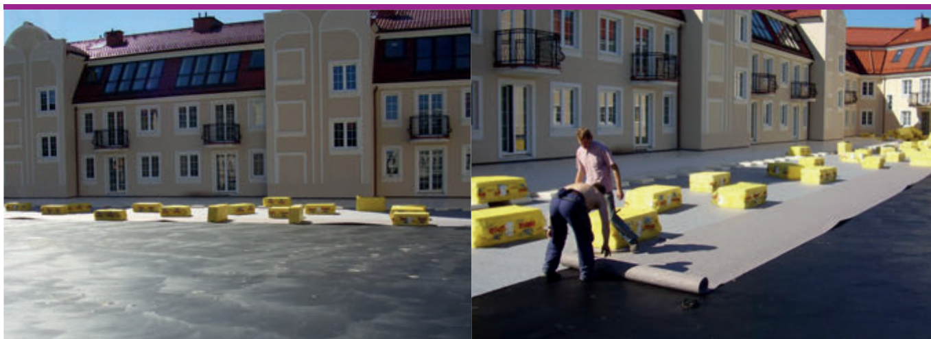
Materiał warstwy zabezpieczającej musi być na tyle wytrzymały, by nie zostać rozerwany przez korzenie roślin.
