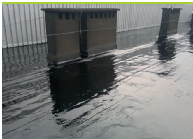
Utworzona powłoka jest gładka i pozbawiona spoin.
