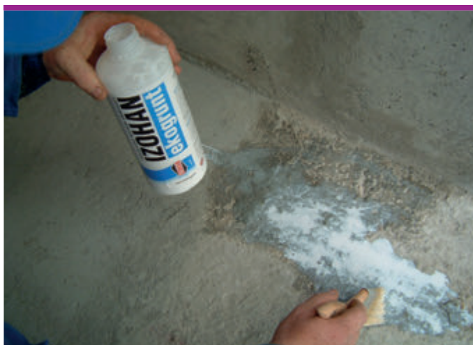
Podłoża silnie chłonne oraz zawierające gips wymagają zagruntowania.
