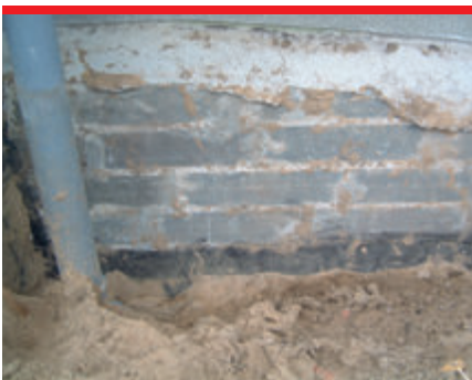
Brak wyciągnięcia izolacji ponad poziom terenu skutkuje zawilgoceniem strefy cokołowej.
