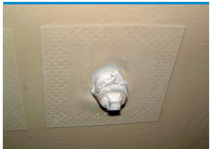
Przejścia rur zabezpieczamy za pomocą manszet ściennych.
