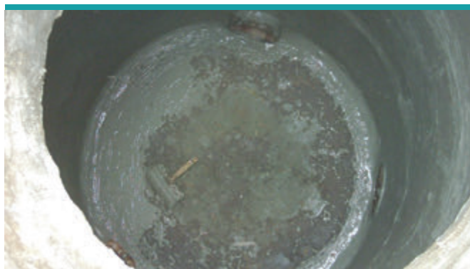
Hydroizolację wykonuje się w kilku operacjach roboczych – nie nakładając w pojedynczej aplikacji warstwy grubszej niż 2 mm.
