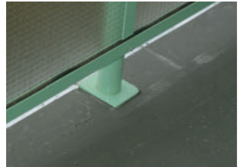
Prawidłowe zabezpieczenie mocowania jest wtopione w powłokę hydroizolacyjną.
