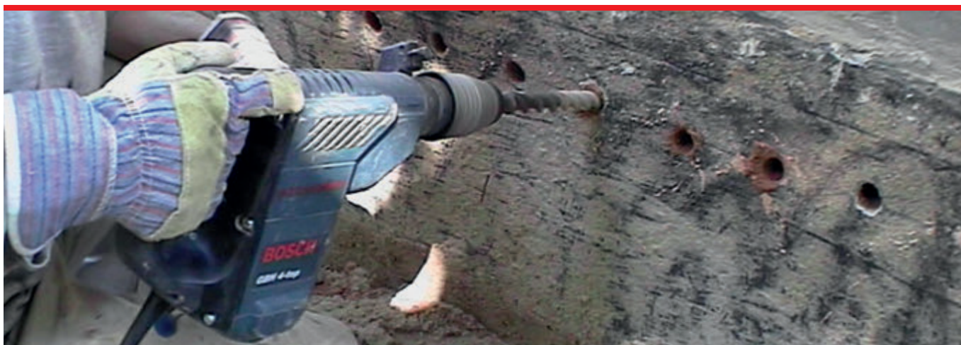
Nie powinno się zapominać o odpyleniu otworów przed wprowadzeniem iniektu.
