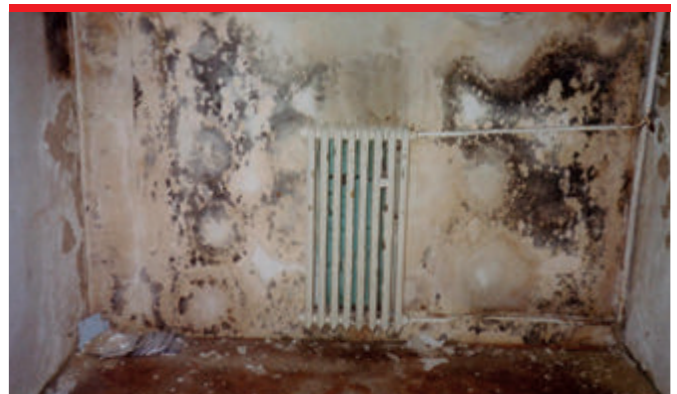
Niesprawna hydroizolacja ściany piwnicy może doprowadzić do bardzo intensywnej inwazji pleśni.
