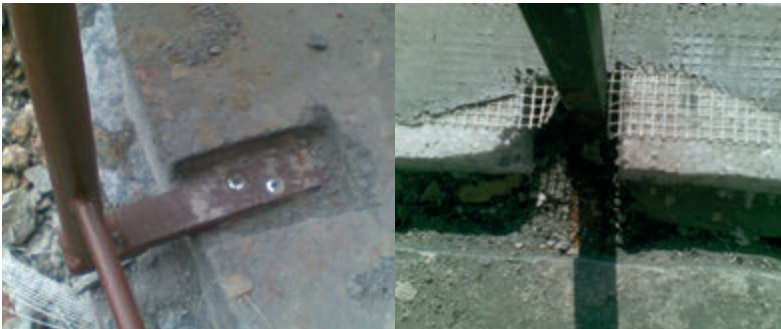
Bez zabezpieczenia przy przytwierdzeniu balustrady od góry powłoka hydroizolacyjna nie zachowa ciągłości, co naraża nas na wystąpienie przecieków w tym miejscu.
