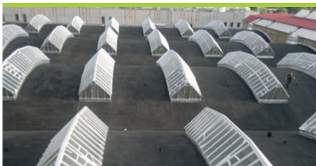
Nawet na dachach o skomplikowanej formie i przy wystających elementach łatwo wykonać pokrycia bezspoinowe.
