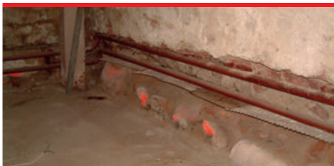
Metody mechaniczne ingerują w konstrukcję budynku.
