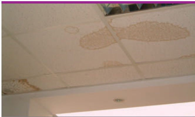
Nieszczelna powłoka izolacyjna grozi zawilgacaniem sufitu.
