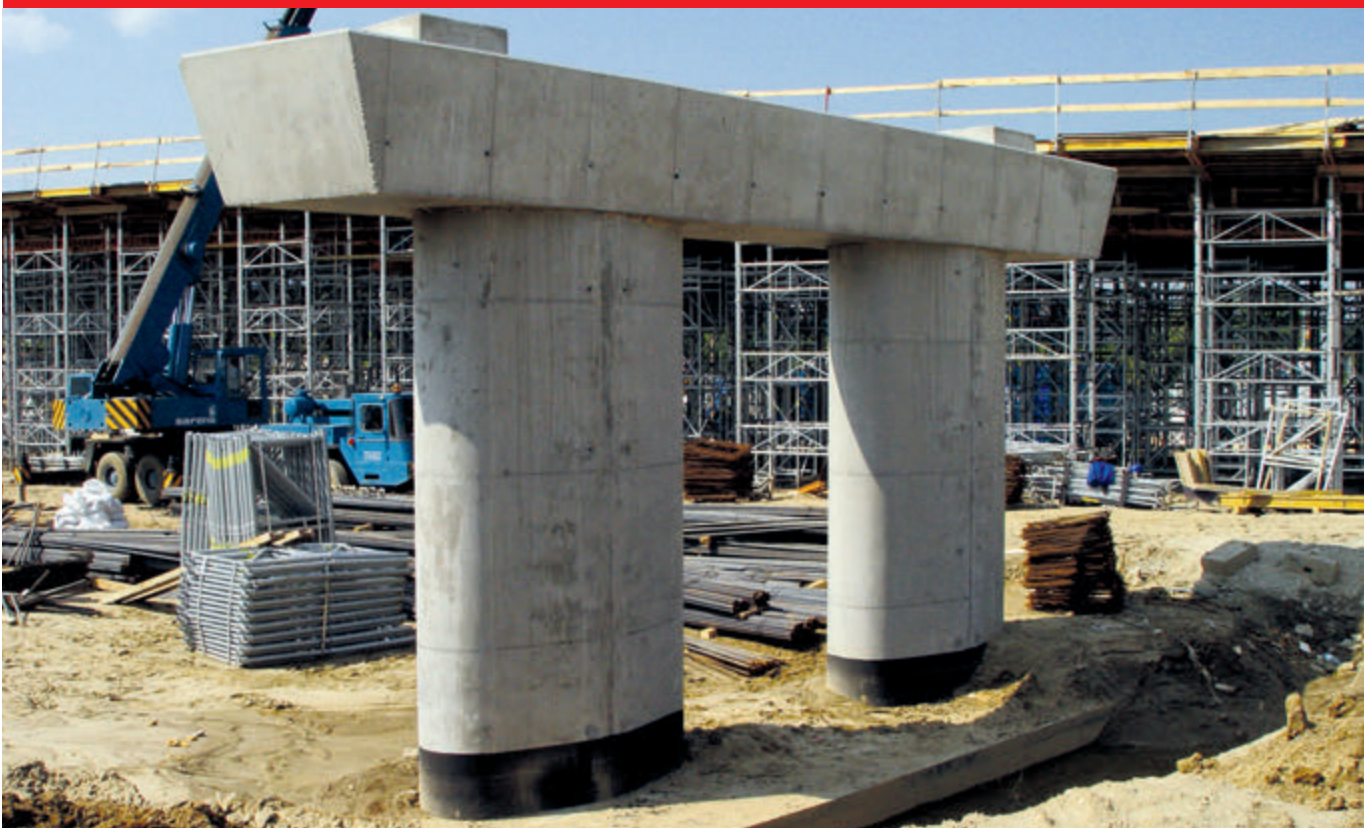
Grunt IZOBUD BR oraz powłoka IZOBUD Gr wykorzystany do izolacji pylonu estakady. Preparaty z serii IZOBUD odznaczają się wysokimi parametrami i znajdują zastosowanie również w budownictwie mostowym.
