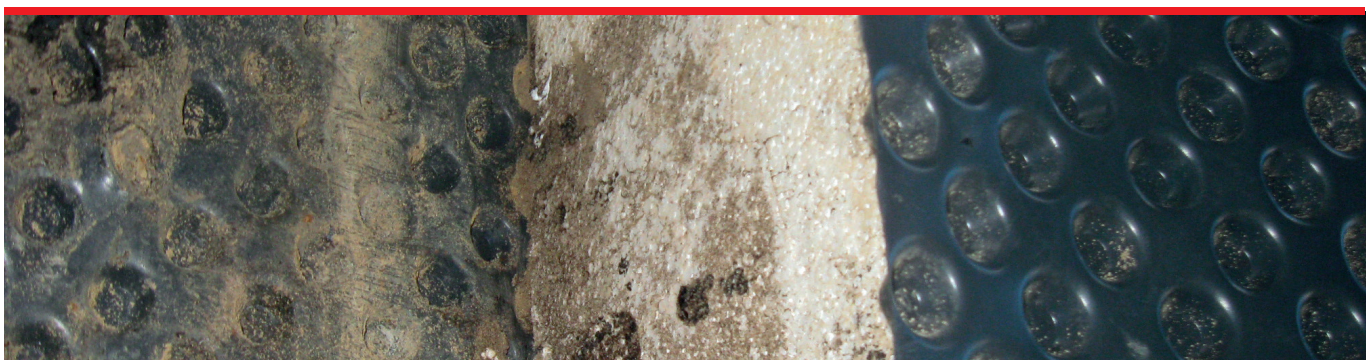
Wyprowadzone ponad poziom gruntu kolnierze folii kubełkowej trudno estetycznie wykończyć. Parcie kubelków folii może deformować i znacznie osłabić warstwę izolacji. Kubelki odciskają się w izolacji.
