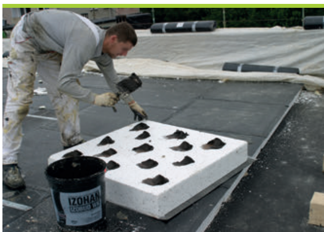
Do klejenia płyt styropapy wykorzystywany jest IZOBUD WK .
