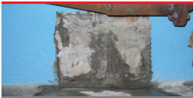
Miejsce przecieku oczyszczamy z luźnych części.
