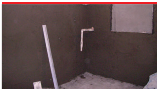
Gotową hydroizolację można wykończyć farbą przeciwwodną lub tynkami renowacyjnymi.
