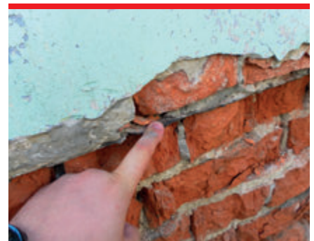
Izolacje poziome z papy na osnowie tekturowej z czasem tracą swoje właściwości izolacyjne.
