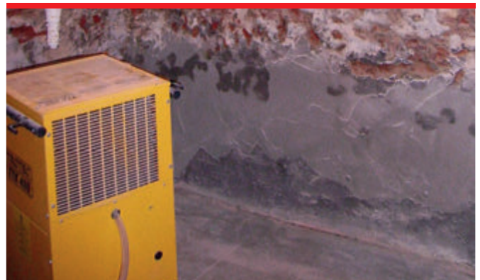
W przypadku mocno zawilgoconych murów i dużej wilgotności powietrza może być konieczne zastosowanie pochłaniaczy wilgoci/nagrzewnic.
