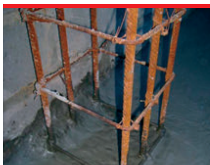
Izolacja płyty wokół wyprowadzonego zbrojenia jest niemal niemożliwa przy wykorzystaniu materiałów rolowych.
