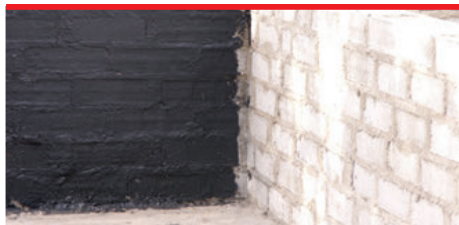
Masy KMB nie wymagają stosowania tynków wyrównawczych (rapówki).
