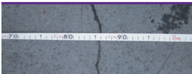
Zbyt krótkie sezonowanie podłoża może prowadzić do problemów z rysami skurczowymi i przyczepnością izolacji.
