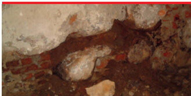
Metod mechanicznych nie stosuje się w murach z przewarstwieniami kamiennymi.
