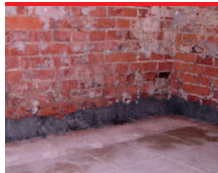
By uzyskać szczelną wannę izolację poziomą odtwarza się także przy ścianach wewnętrznych.
