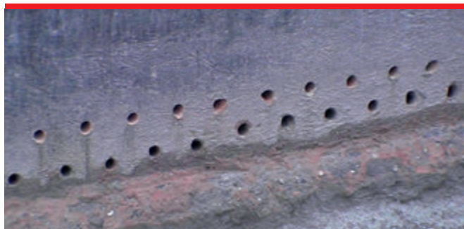
Iniekcję dwurzędową stosuje się w murach o dużej grubości lub jako dodatkowe zabezpieczenie.
