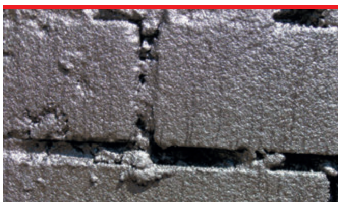
Szczeliny w murze niepełnospoinowym przed nałożeniem izolacji powinny być uzupełnione.
