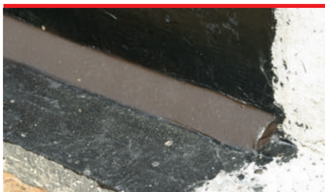
Faseta wykonana z masy KMB. Świeżo wykonana faseta z dyspersyjnej masy bitumicznej ma kolor brązowy.
