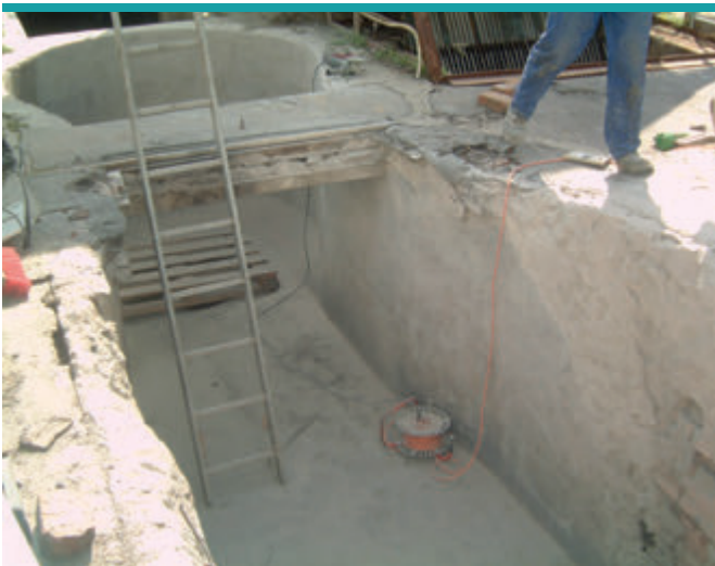
Podłoże powinno być wyrównane, suche, czyste i nośne.
