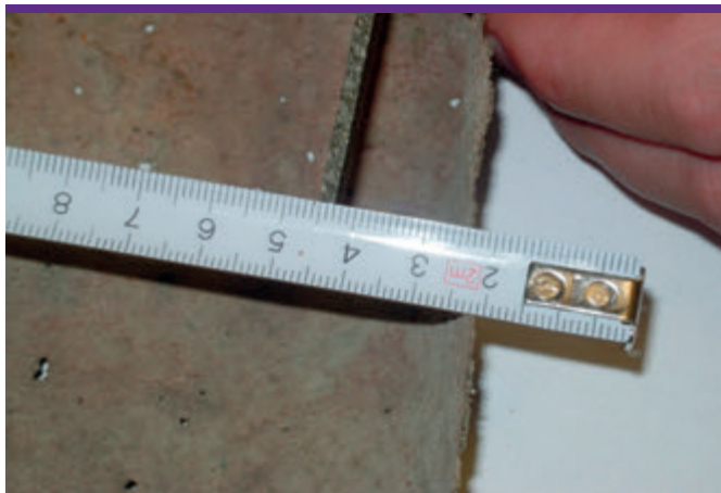
Porównanie grubości izolacji wzorcowej i błędnie wykonanej, zbyt cienkiej warstwy.
