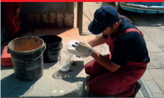
Przed zastosowaniem wodochron W należy rozcieńczyć z wodą w proporcji 1:9.
