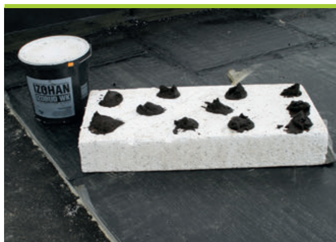
Pokrycie płyty klejem musi się zwiększyć na krawędziach i brzegach dachu, gdzie wiatr oddziałuje najsilniej.
