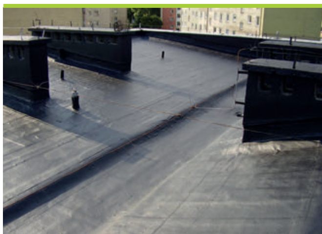
PO – uzyskano pokrycie pozbawione miejsc krytycznych – szwów
