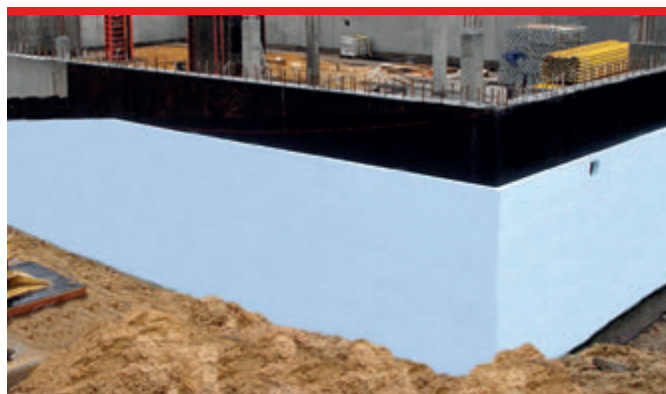
Przyklejając płyty styropianowe należy stosować się do instrukcji podanej w karcie technicznej wyrobu.
