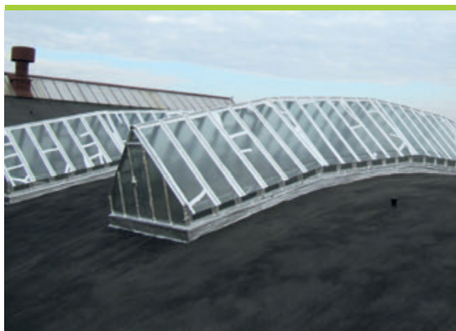
PO – izolacja w obrębie świetlików odbyła się bez zmuszającego dopasowywania i docinania. Świetliki pokryto preparatem IZOBUD R .
