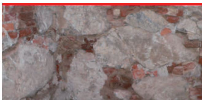
Iniekcja dwurzędowa zalecana jest w murach z przewarstwieniami kamiennymi.
