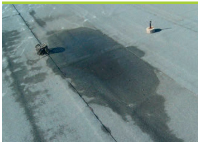
Przecieki mogą wynikać z nieprawidłowego wyprofilowania spadków na powierzchni dachów.
