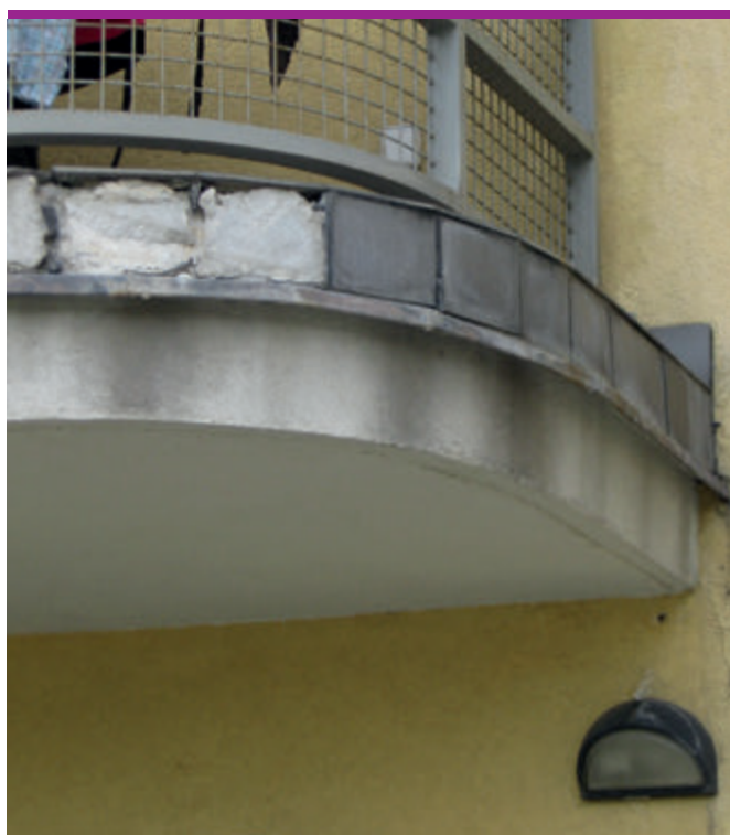
Błędy na etapie wykonawstwa mogą też skutkować odpadaniem płytek.
