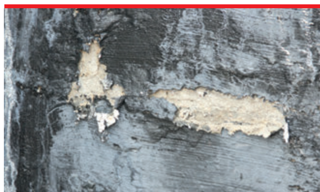
Nie nakłada się mas na podłoża wilgotne, z zastoiskami wody, bo może to prowadzić do odpadania powłoki.
