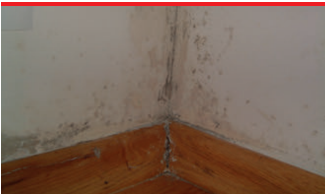
Na niedostatecznie ocieplonych ścianach kondensuje się woda, stwarzając doskonałe warunki dla pleśni.
