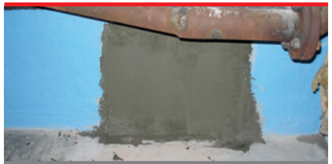
Przeciek tamujemy zaprawą szybkowiązającą.
