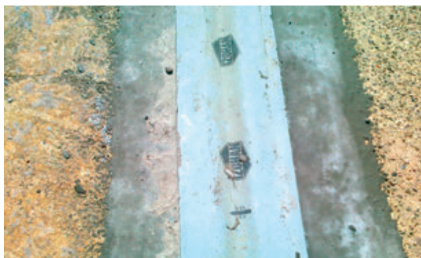
IZOHAN taśma uszczelniająca dwukrotnie powlekana wtapiana w izolację.
