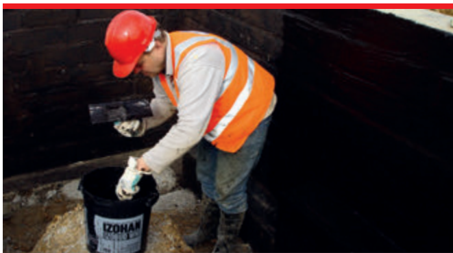
Powłokę nanosi się zawsze na stronę narażoną na działanie wody. Nie wolno stosować mas KMB w przypadku ciśnienia ujemnego.
