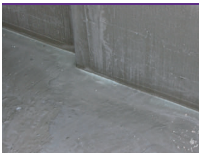
EKO 2K pozwala uzyskać elastyczną bezspoinową powłokę izolacyjną.
