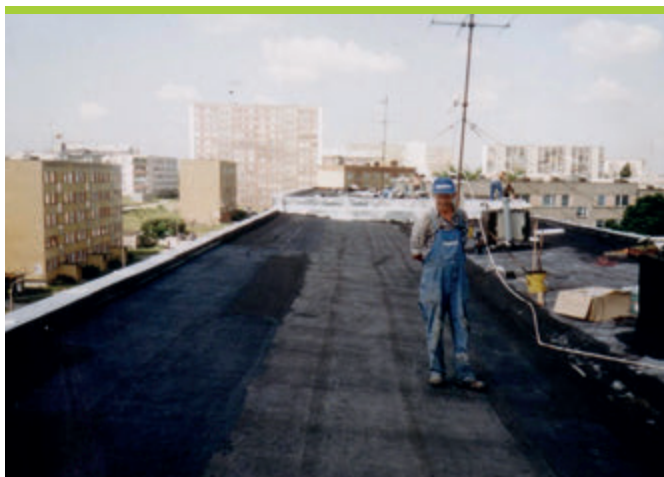
Prace odbywają się bez żmudnego dopasowywania, docinania, przestrzegania zakładów.
