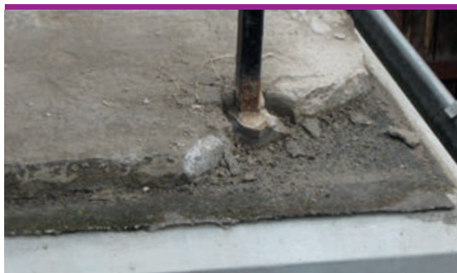
Mocowanie balustrady od góry ma wiele wad.
