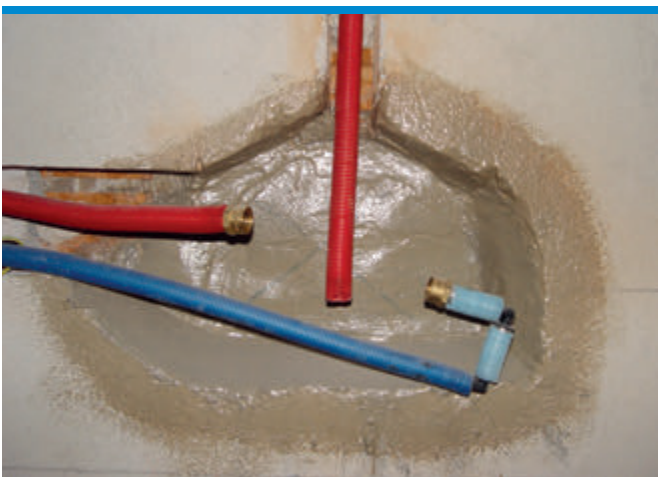
W miejscach niewralgicznych hydroizolacja może się składać nawet z 3 warstw.
