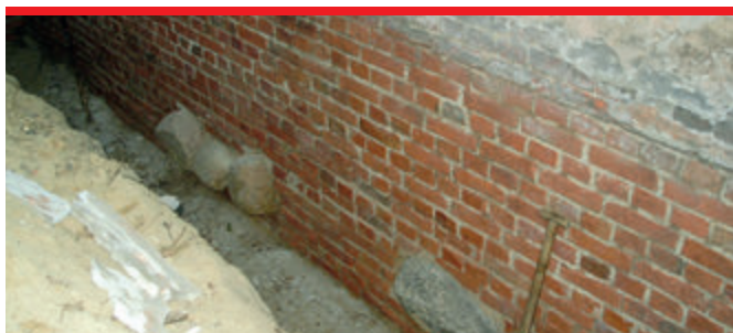
Możliwość aplikacji mas typu KMB na podłożach o skomplikowanych kształtach np. w przypadku przewarstwień kamiennych.
