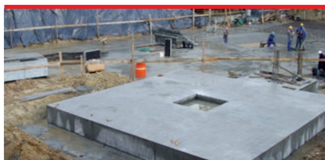
Masy KMB systemu IZOBUD W można stosować na suchym lub matowo wilgotnym podłożu. Nie dopuszcza się zastoin wody.
