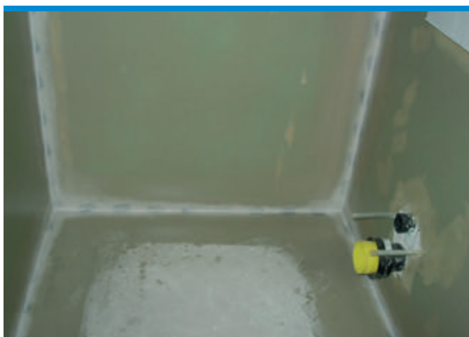
Produkty systemu IZOHAN EKO można stosować nawet na podłoża łatwo wchłaniające wilgoć (takie jak płyty g-k).
