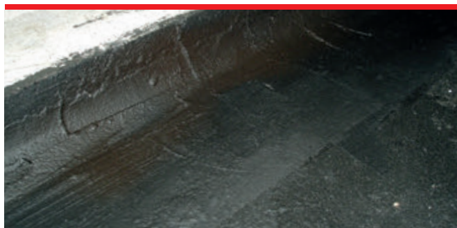
Jeśli jako izolację poziomą stosujemy papę zgrzewalną lub inny materiał bitumiczny, to faseta wykonujemy także z masy bitumicznej KMB.
