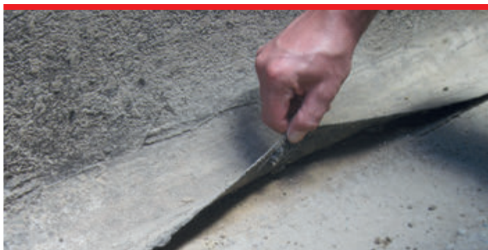
Próba łączenia folii budowlanej z masą bitumiczną zakończona porażką.
