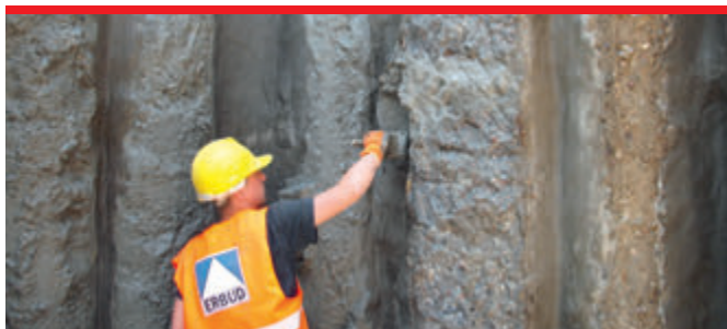
Izolacje ściany palisadowej można wykonać produktami systemu mineralnego.
