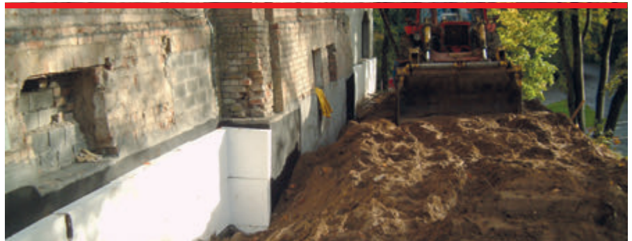
Płyty polistyrenowe EPS lub XPS łączą funkcje ochrony termicznej i mechanicznej.
