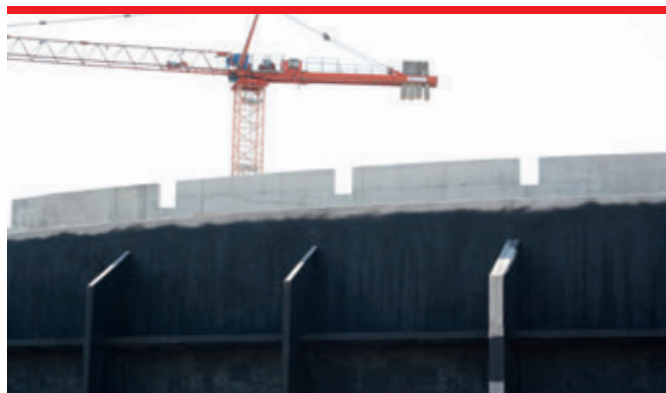
System IZOBUD W zastosowany na ścianach oporowych w Hali Widowiskowo-Sportowej w Gdyni.
