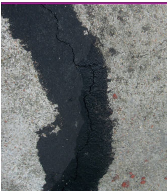
Pęknięcia podłoża – skutek działania skurczu i braku dylatacji.
