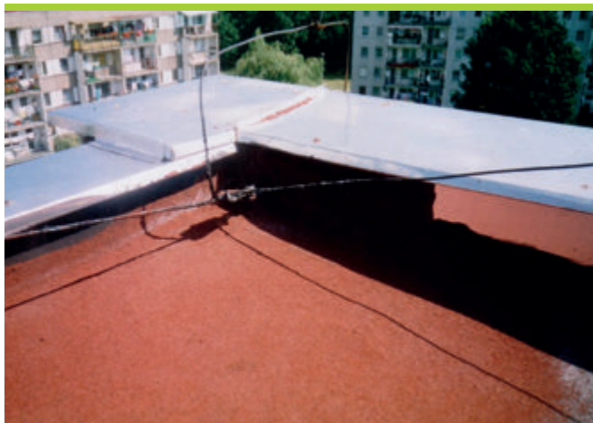
Zastosowanie posypki papowej na powłoce z IZOBUDu B zwiększa żywotność pokrycia.
