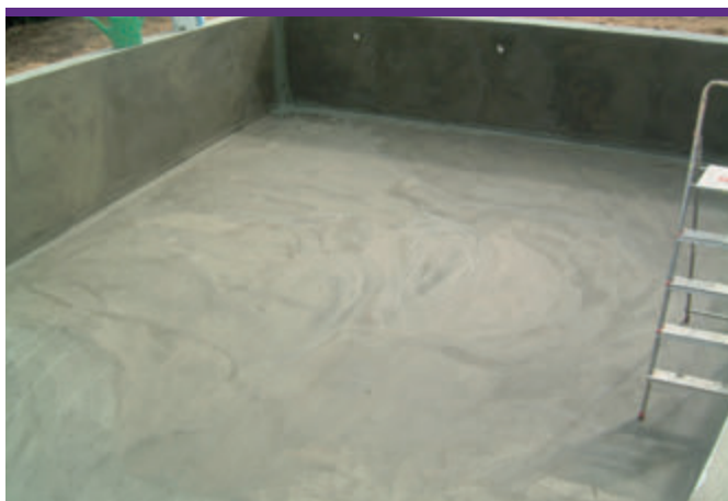
Niecka basenowa zewnętrzna zaizolowana EKO 2K (ekofolia wysokociśnieniowa 2-skl.).
