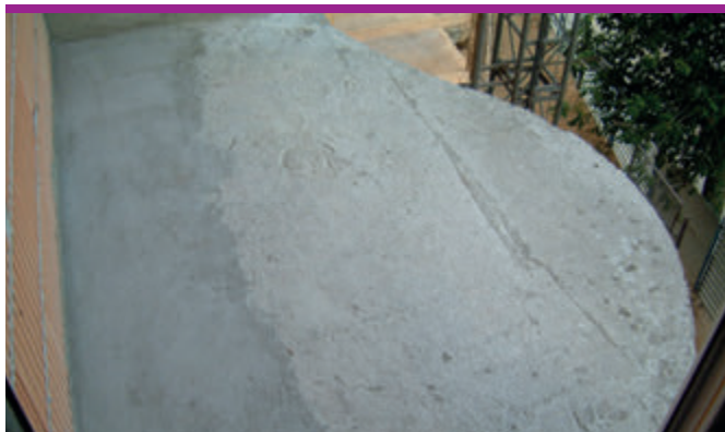
Podłoże powinno mieć czystą, gładką i chłonną powierzchnię.
