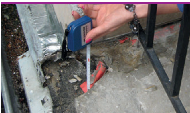
Należy zachować odpowiednie grubości każdej z warstw.
