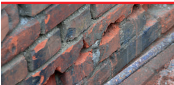
Ubytki w podłożu powinny być uzupełnione, a spoiny dobrze wypełnione.
