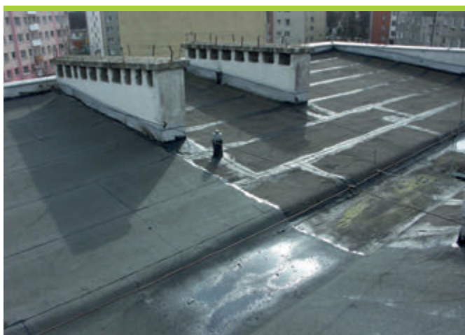
PRZED – pokrycie papowe wymagało renowacji.
