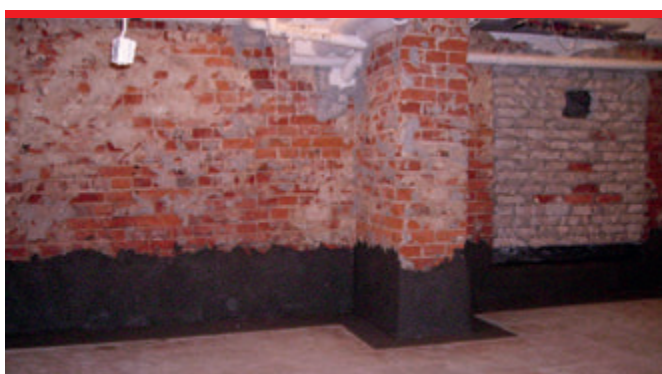
W pierwszej kolejności wykonujemy prace w obrębie połączenia pion-poziom.
