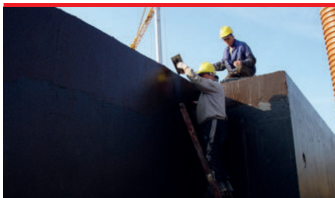
Aplikacja mas KMB jest łatwa nawet w warunkach ograniczonego dostępu i przy użyciu najprostszych narzędzi.
