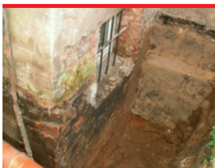
Na nieregularnych powierzchniach i przy przejściach instalacyjnych łatwo o błąd.
