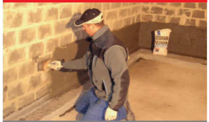
Aby uzyskać ciągłość izolacji preparat należy nanieść także na wewnętrzną stronę ściany ponad izolację poziomą.
