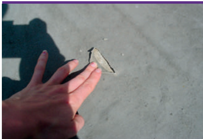
Skutki nałożenia zbyt cienkiej powłoki izolacyjnej. Na budowie należy kontrolować grubość warstwy.
