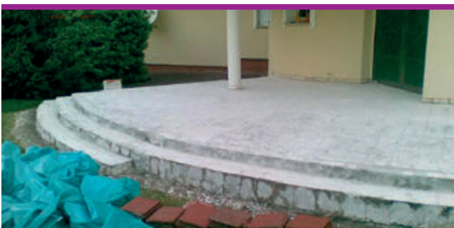
Remont tarasu na gruncie.
