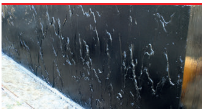
Nakładanie warstw dużo grubszych niż zalecane może prowadzić do spływania masy po ścianie.
