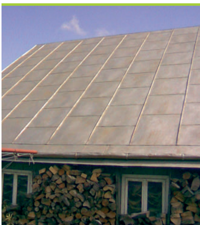
IZOBUD R zaaplikowany na blachę. Odświeża wygląd i ogranicza nagrzewanie się dachu.
