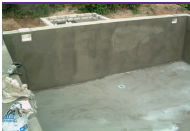
Okładziny ceramiczne można przyklejać bezpośrednio na warstwę izolacji po upływie 24 h.
