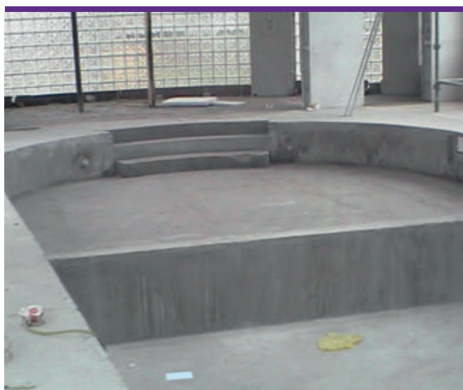
Podłoże powinno być równe, czyste i suche. Przed wykonaniem izolacji należy przeprowadzić próbę wodną.
