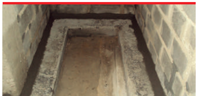
W miejscu styku ściany i posadzki wykonuje się wydrę uszczelniającą i formuje fasetę.
