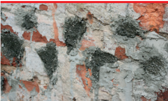
Po nasyceniu muru preparatem iniecyjnym otwory zasklepiamy specjalistyczną zaprawą typu PCC renobud R-103 .
