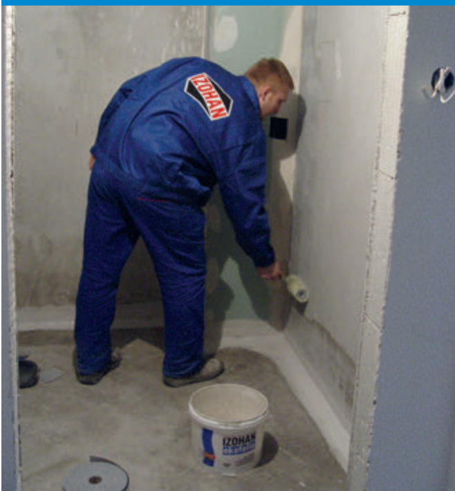
Powłokę hydroizolacyjną nakładamy za pomocą pędzla lub wałka w 2-3 operacjach roboczych.
