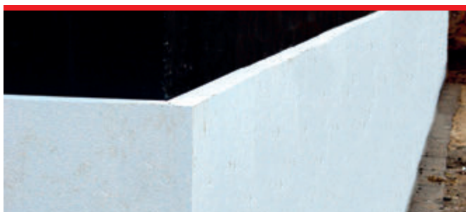
System dyspersyjny świetnie nadaje się do wykonania fundamentów ocieplonych.
