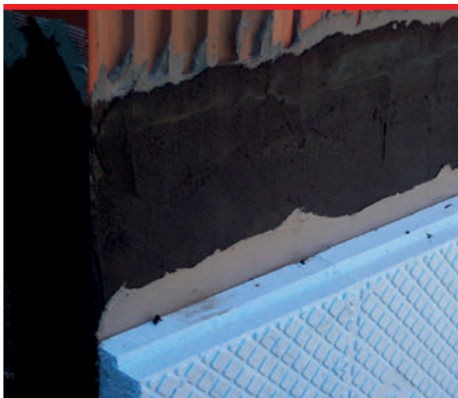
Ekolep 2002 odseparowuje ocieplenie od izolacji rozpuszczalnikowej.
