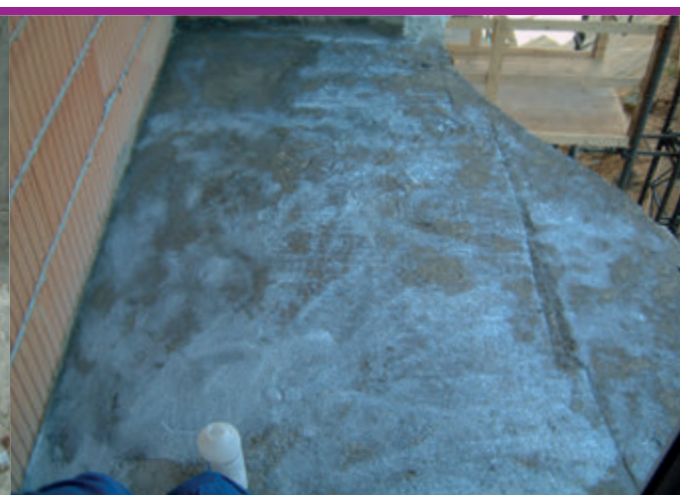
Badanie wilgotności płyty balkonowej – nie powinna przekraczać 7%.
