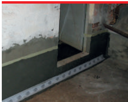
Przejście pion-poziom zabezpiecza się za pomocą taśmy uszczelniającej.
