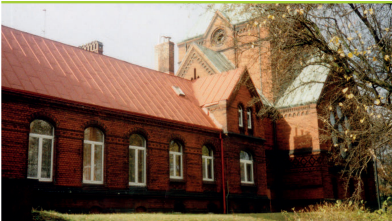
Ekodach w kolorze czerwonym zastosowany na dachu zabytkowego kościoła w Gliwicach.
