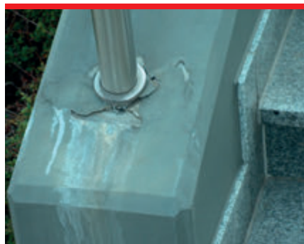
Brak izolacji otwiera drogę dla niszczącego działania soli.
