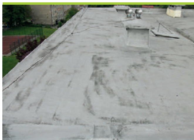
Zastosowanie posypki papowej, IZOBUDu R lub ekodachu wydłuży trwałość pokrycia.
