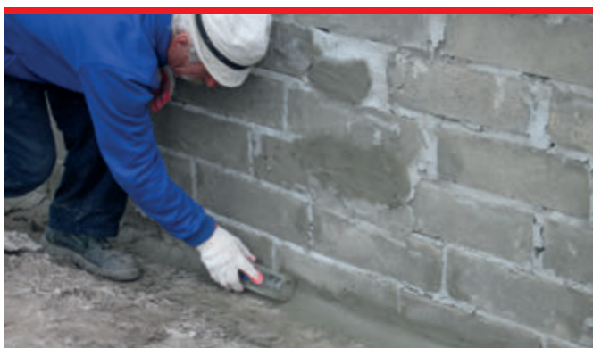
Prostym sposobem na wykonanie fasety z zapraw PCC jest posłużenie się zwykłą butelką.
